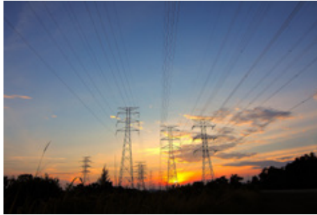
cable clouds danger 171428.jpg
